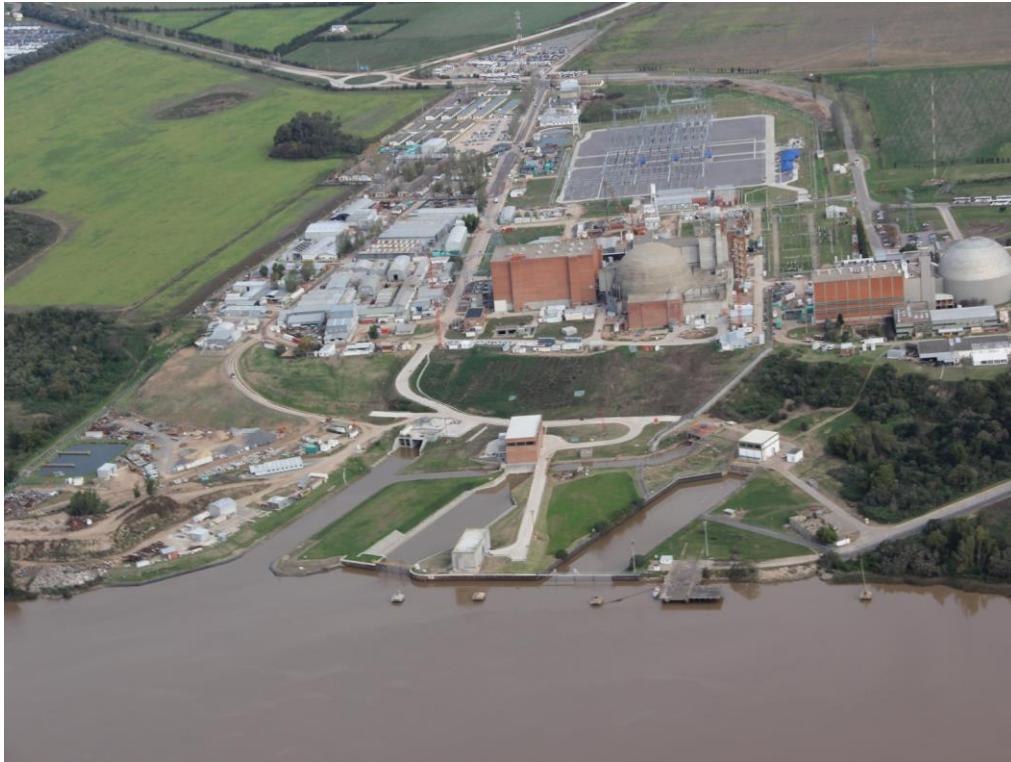
Foto: Vista aérea de la Central Nuclear Atucha II
