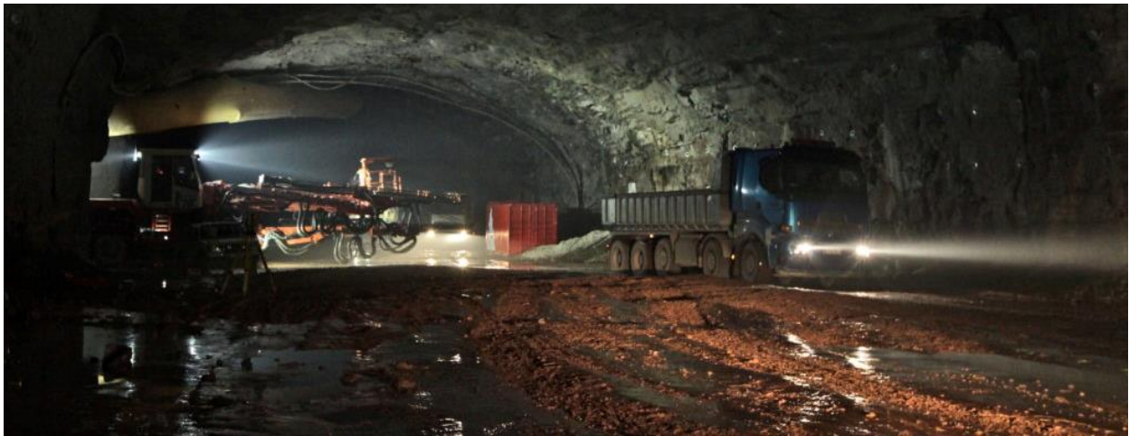
Länsimetro tunneling nearing completion (photo courtesy Länsimetro / Timo Kotineva)
