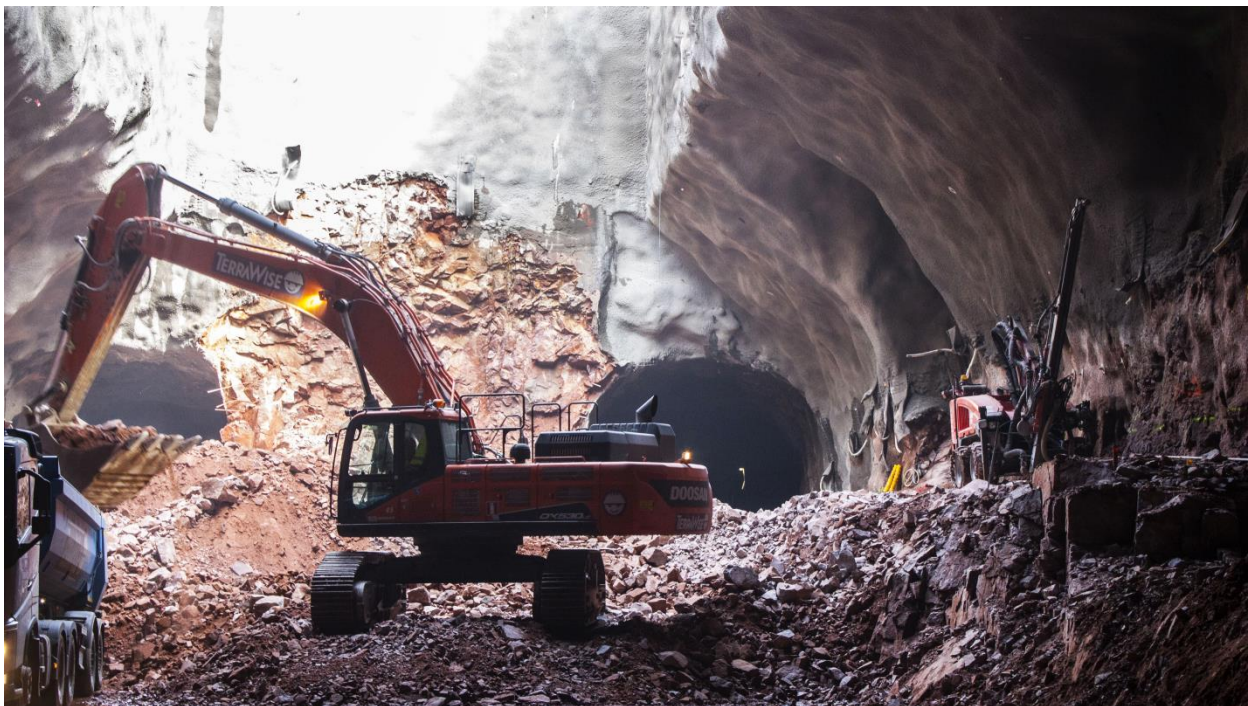
Länsimetro tunneling works progressing (photo courtesy Länsimetro / Saija Räsänen)
