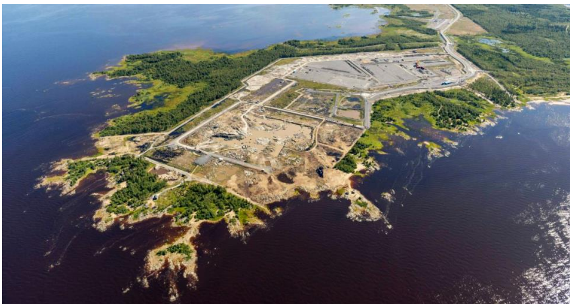
The Hanhikivi 1 construction site (photo courtesy Hannu Vallas / Lehtikuva)
