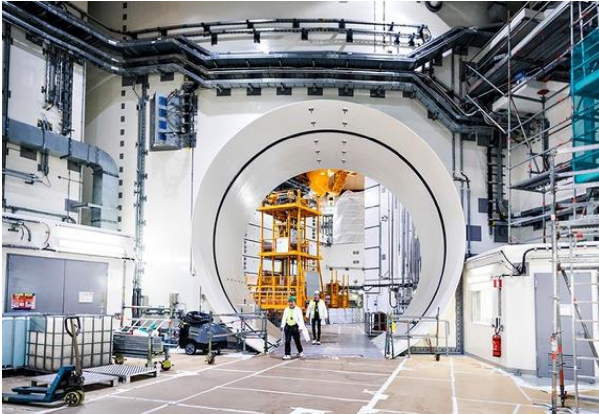
Olkiluoto 3 is nearing completion (photo courtesy Tiina Somerpuro / Kauppalehti)
