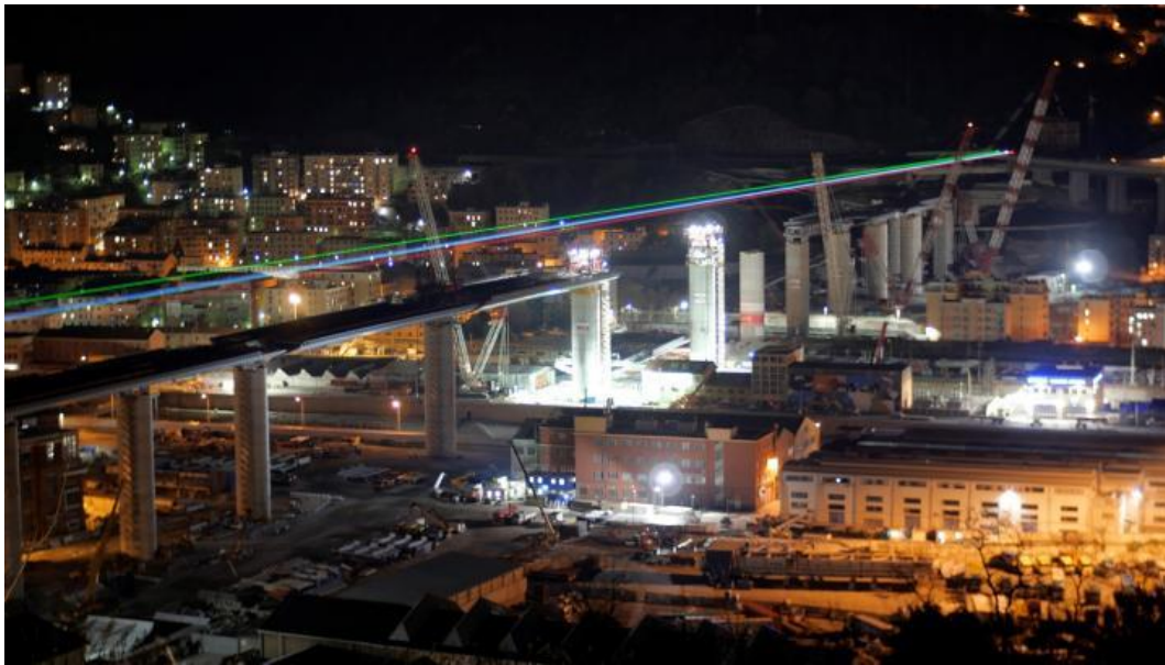
"Ponte di Luce per Genova", cortesia del Gruppo Salini Impregilo
