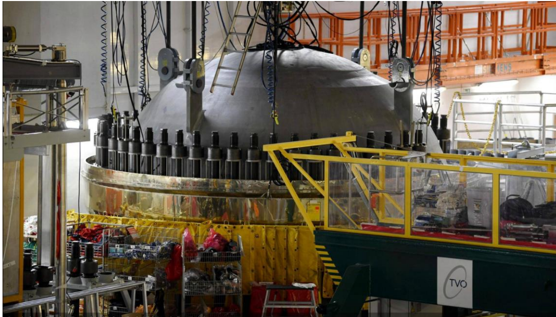
Olkiluoto 1 pressure vessel in 2018 shutdown (photo courtesy Antti Aimo-Koivisto / Lehtikuva)
