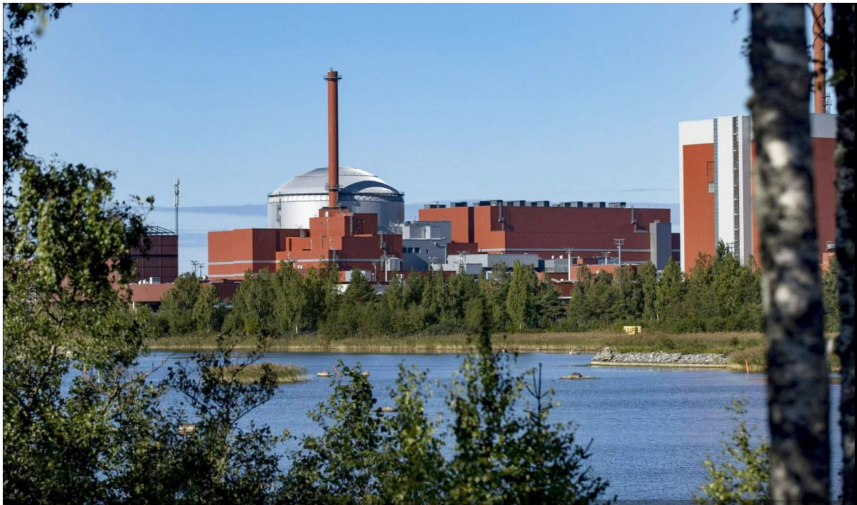
Olkiluoto 3 power station is now completed (photo courtesy Roni Lehti / Lehtikuva)
