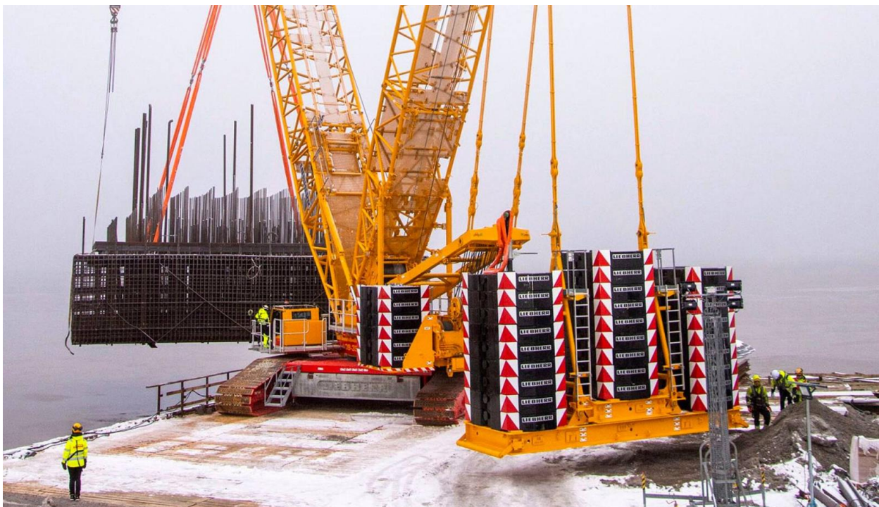
Lowering of Kruunuvuorensilta pylon foundations (photo courtesy Jussi Laamanen / Kruunusillat)
